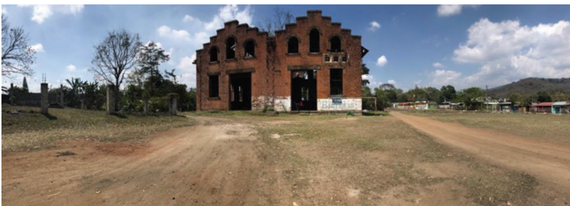
Figura 6. La subestación de potrero es uno de los dos edificios que suministraban energía eléctrica al ferrocarril. Un edificio con características idénticas el cual también funcionaba como subestación, se encuentra en Maltrata, Puebla. De acuerdo con el testimonio de Nazario Cebada, habitante de Potrero, ambas estaciones fueron construidas en la segunda década del siglo XX. Fotografía: Arely Cárdenas. 16 de marzo de 2020.
