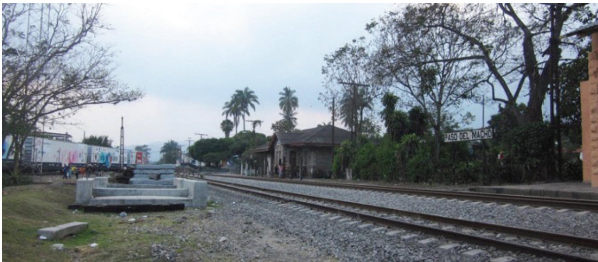
Figura 4. Vista panorámica de la Estación de Paso del Macho. Fotografía: Arely Cárdenas. 14 de marzo de 2020
