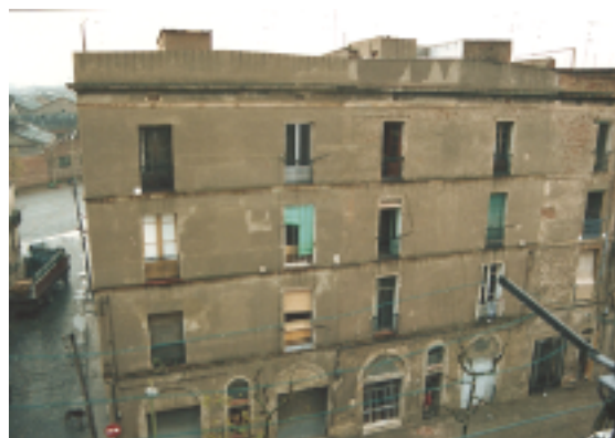
Figura 12. Edificio de vivienda en la calle Àlaba
