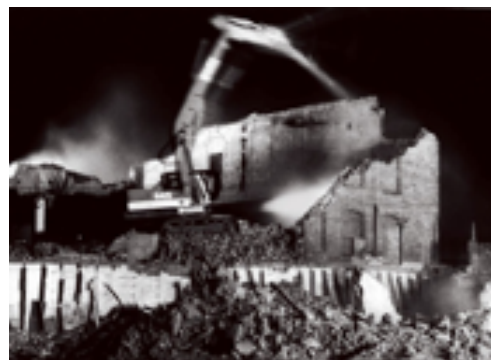
Figura 9. Derribo de edificaciones
