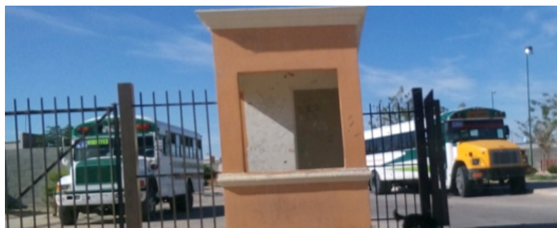
Figura 7. Casetas de seguridad abandonadas
