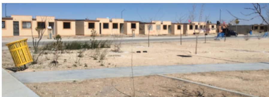
Figura 5. Casas abandonadas y parque descuidado
