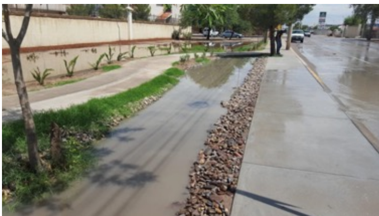
Figura 7. Captura de agua de lluvia en las microcuencas del parque Valle del Sol
